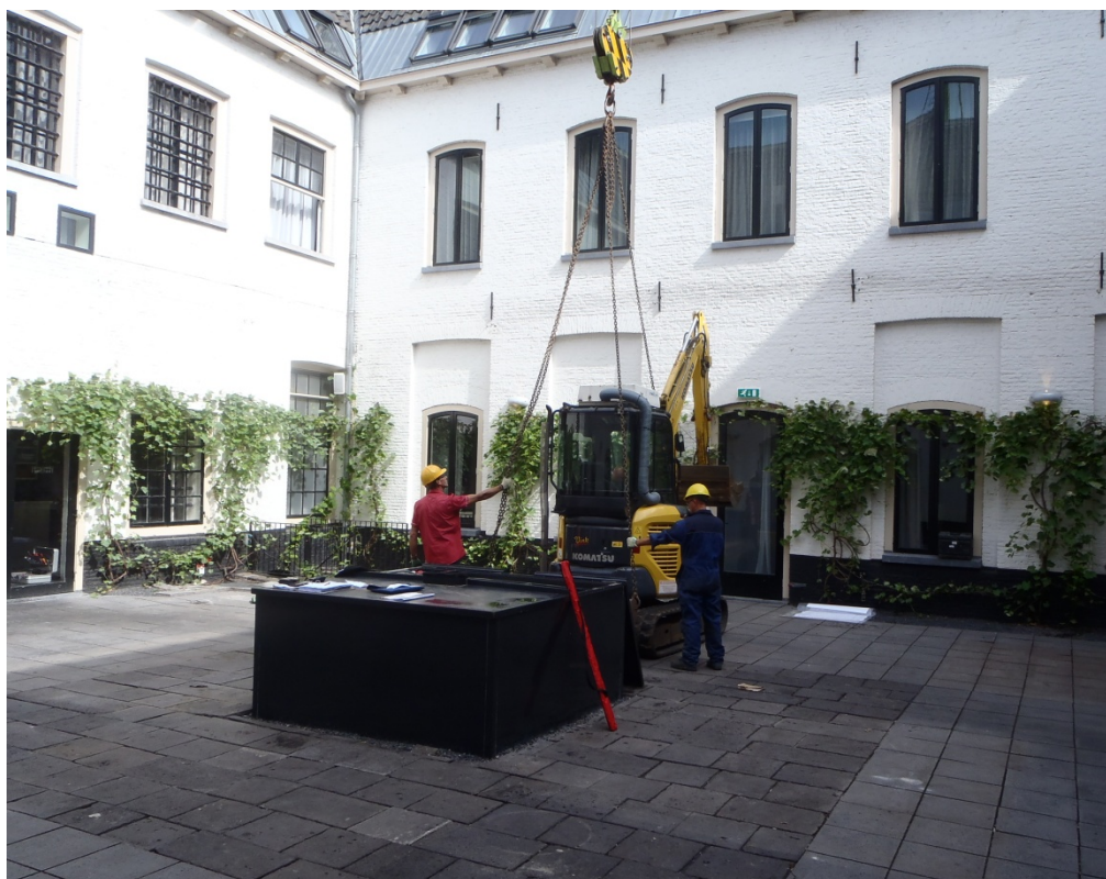
Afb. 7. Eén van de graafmachines wordt op de binnenplaats gehesen.
