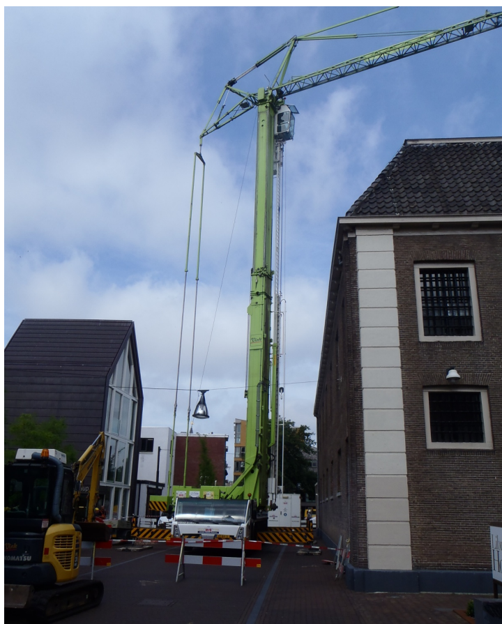
Afb. 6. Aan- en afvoer van machines, materiaal en grond ging via een telekraan over het dak.
