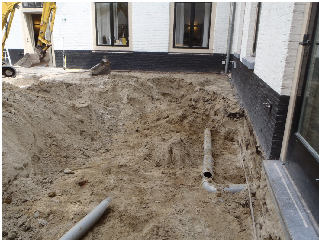
Afb. 9. Afgraven van de binnenplaats met 40 à 50 cm.
