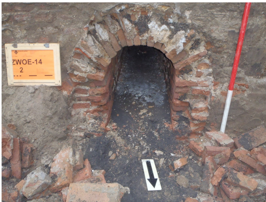
Afb. 13. Doorsnede van het gemetselde riool.
